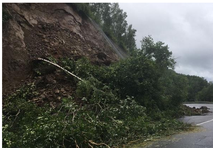
Рис. 6. Оползень в Слюдянском районе, восточный берег Южно-Байкальской котловины Байкальского региона [13]
