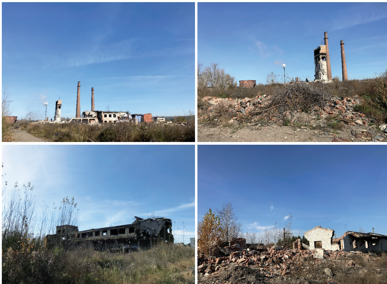
Рис. 1. Разрушенные цеха на промплощадке бывшего завода «Востсибэлемент», октябрь 2024 г. (фото авторов)
